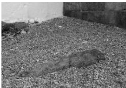
Sokkelsten i hjrnet mellem tårnet og våbenhuset.
